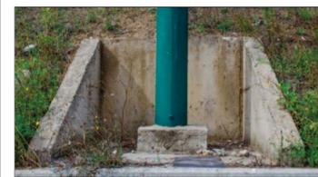
PARTICOLARE ALLOGGIAMENTO PALO IN PROSSIMITA' DI TERRENO IN PENDENZA
