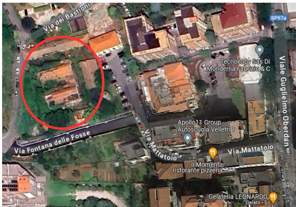
Ortofoto di localizzazione complesso Ex Mattatoio
