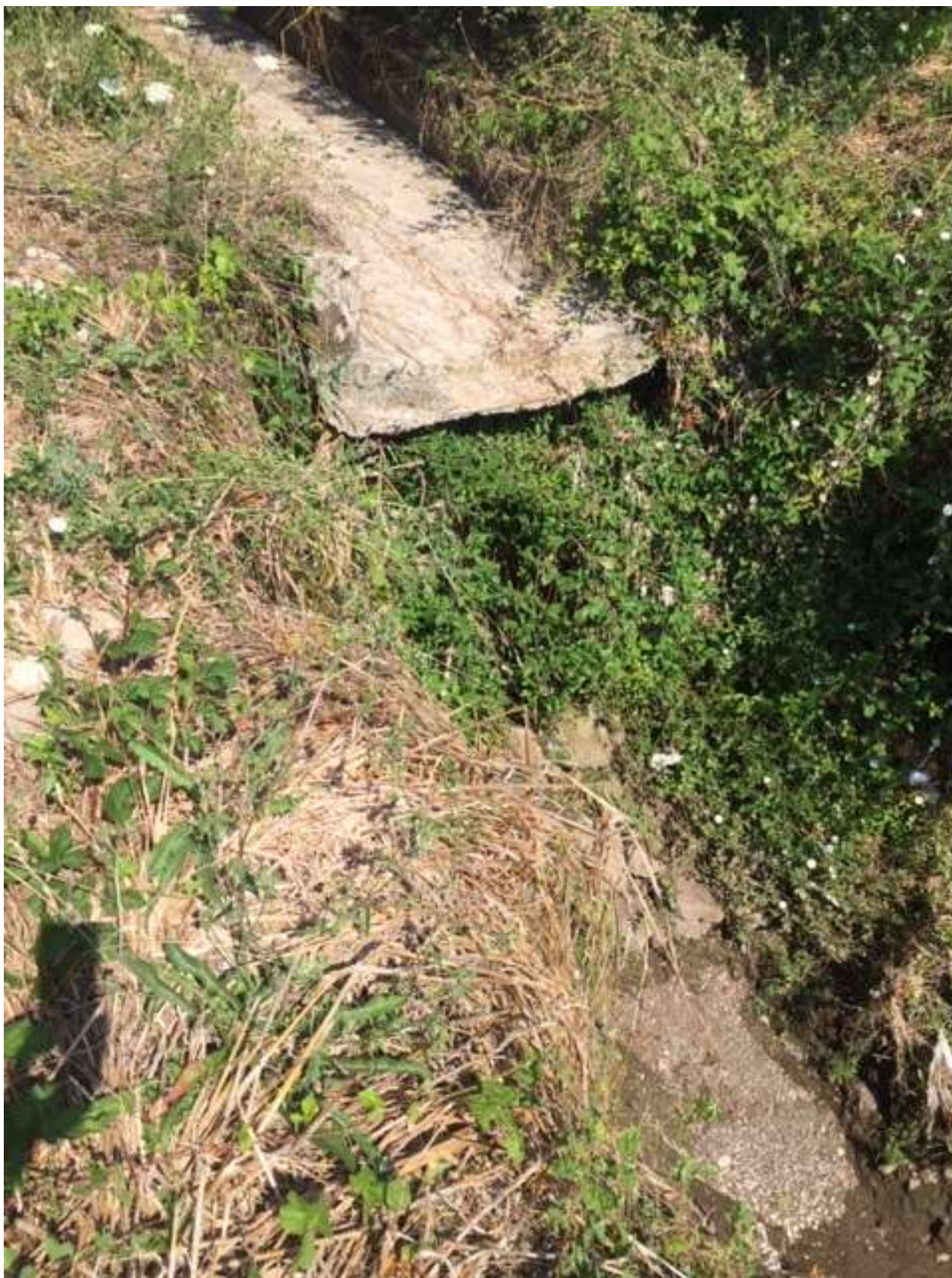
Figura 12 - Passaggio da canaletta cementata a fosso naturale
