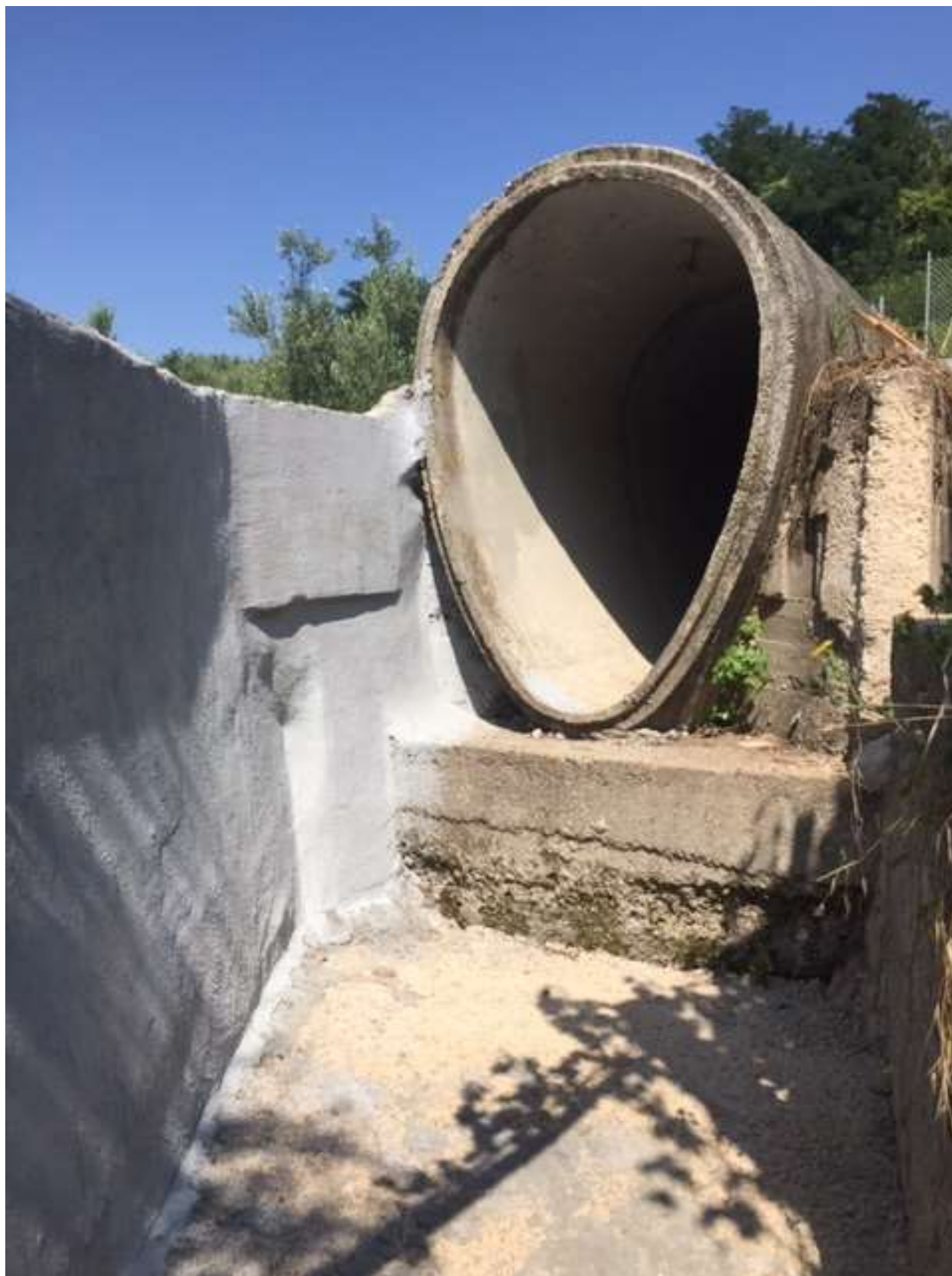
Figura 6 - Sezione terminale dello scarico ACEA
