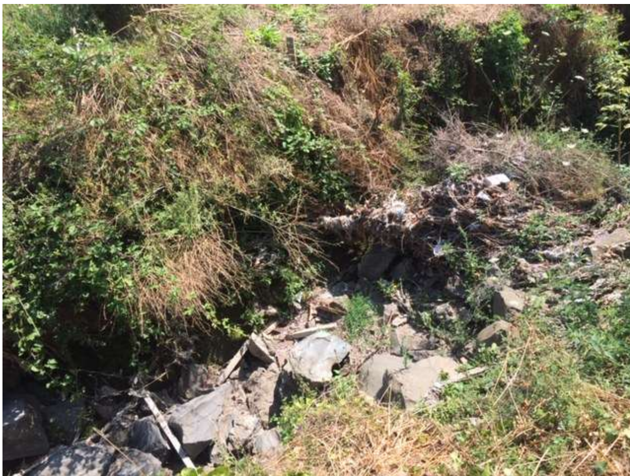
Figura 13 - Fondo del fosso immediatamente a valle del passaggio da canaletta a fosso
