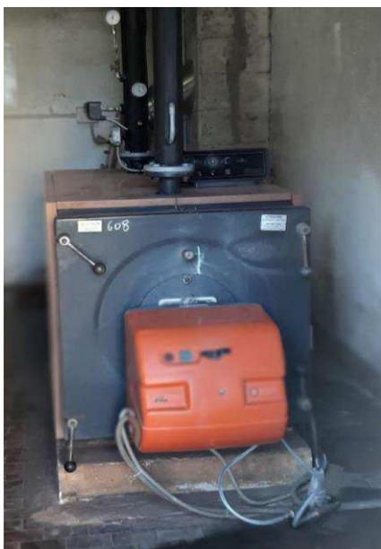
Figura 2: Caldaia a gasolio
