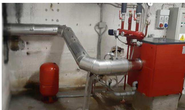
Figura 2: Caldaia a gasolio
