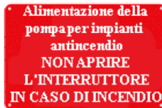
Cartello che segnala l'interruttore sulla linea di alimentazione di una pompa
