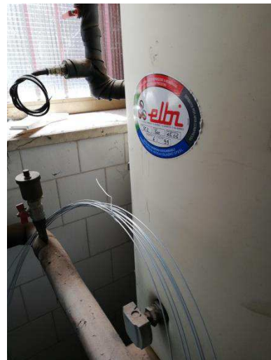
Figura 7: Sistema di accumulo ACS
