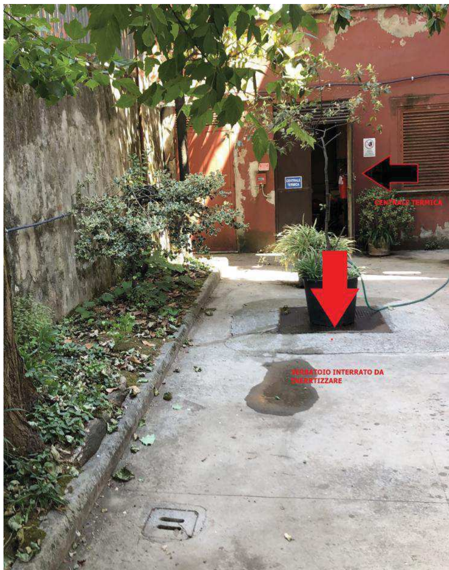
Vista centrale termica e localizzazione botola accesso serbatoio gasolio.
