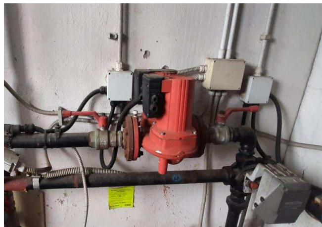
Figura 3: Elettropompa di alimentazione
