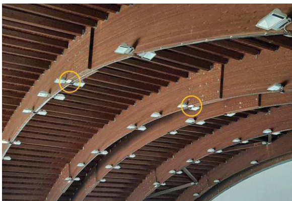
Quadro attuale e lampade di emergenza
