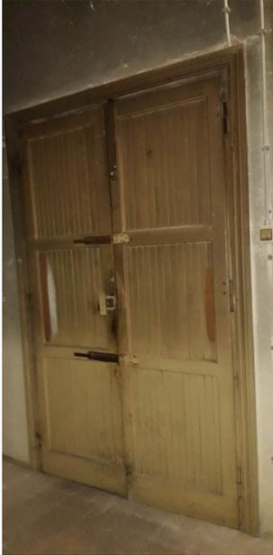
17) Al piano secondo è da sostituire la porta-finestra chiamata **C1** di cui alla foto 101s che affaccia sul terrazzino la quale dovrà essere realizzata apribile verso l'interno e le sue dimensioni sono di m 1,20 di larghezza per un'altezza di m 2,80 per mq 3,36.
