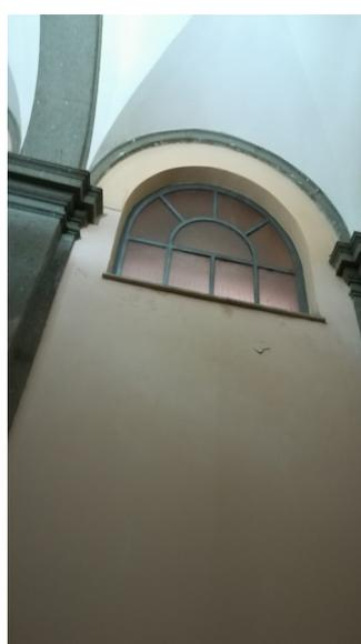
3) - 4) Nello Scalone d'Onore vi sono due finestre poste al mezzanino (quota 1 + ½) costituite ognuna da due parti: una in alto centinata di m 1,70 di larghezza per un'altezza compresa la centina di m 4,30, mentre l'altezza presa alla base è di m 3,45 per mq 7,31 vpp ed una in basso rettangolare di larghezza pari a m 1,70 e di altezza di m 2,10 per mq 3,57.
