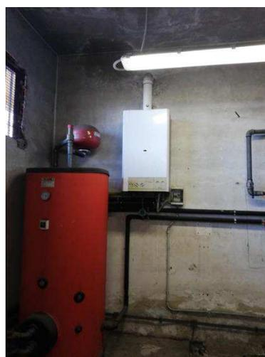
Figura 3: Produzione Acqua Calda Sanitaria
