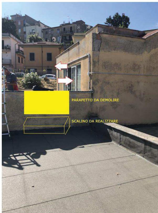
L'accesso alla copertura sulla quale verrà installato l'impianto solare termico dovrà essere realizzato poiché allo stato attuale esiste un muretto (parapetto) che deve essere scavalcato con il rischio di caduta. Successivamente alla demolizione dovrà essere installato un cancello di pari altezza del parapetto presente dotato di serratura e chiave.
